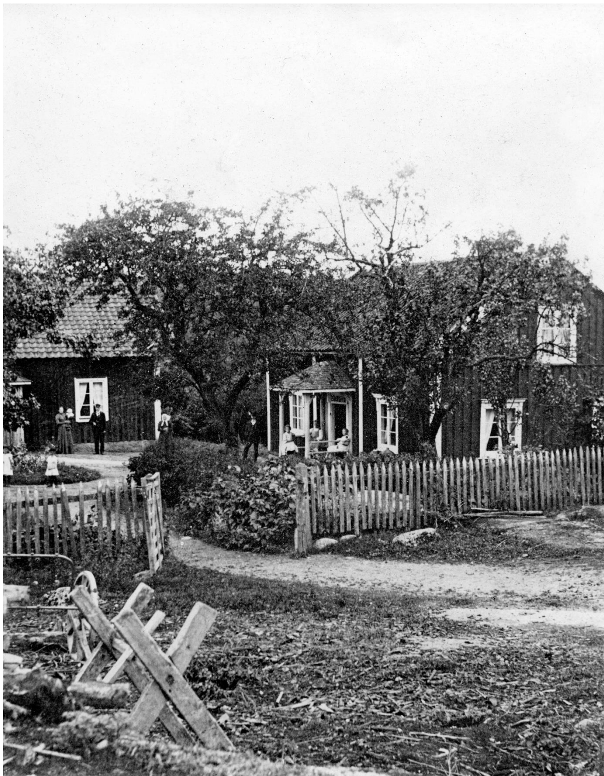
Gamla mangårdsbyggnaden i Värna 1:3. Den revs omkring 1950 av Erik Fransson i Rimforsa för att återuppföras i samhället. Det blev emellertid inte utförts.
